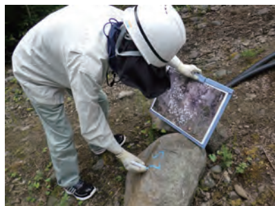
写真1 崩落石材の仮番付
