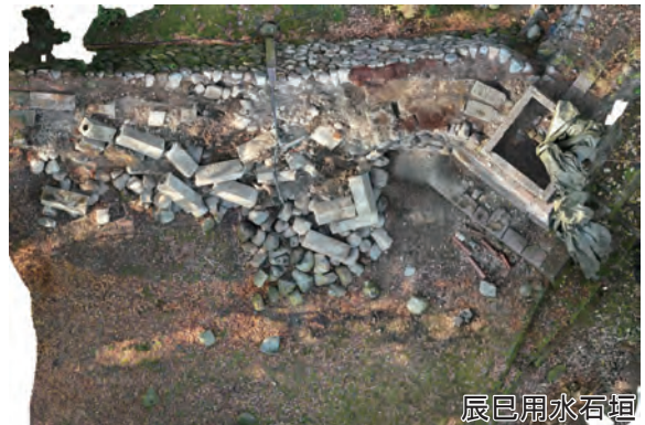
辰巳用水石垣 石垣崩落状況 辰巳用水石管を含む約170石が崩落。石材81石を回収し、同定作業を実施。
