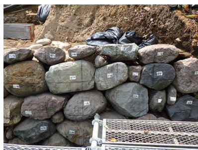
写真4 石垣へ墨打ち
