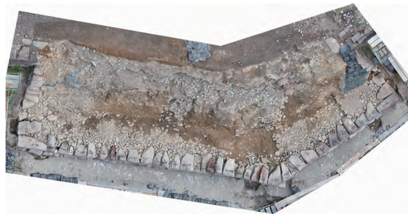
玉泉院丸南西石垣 石垣解体状況 平成20年の修理箇所が、大きく前倒れたため、石材151石を解体した。
