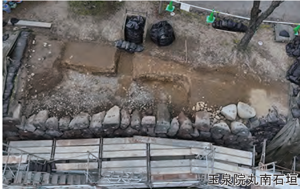
石垣1段階解体後の状況 昭和40年代に体育館通路造成時に改築。石材50石を解体した。
