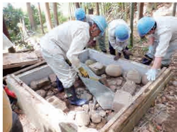
輪島市「中段の板碑」救出作業
