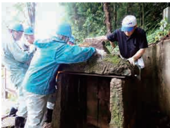
七尾市「新保町の石龕と宝篋印塔」復旧作業
