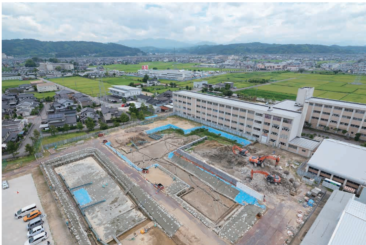
調査地遠景（北西から）
