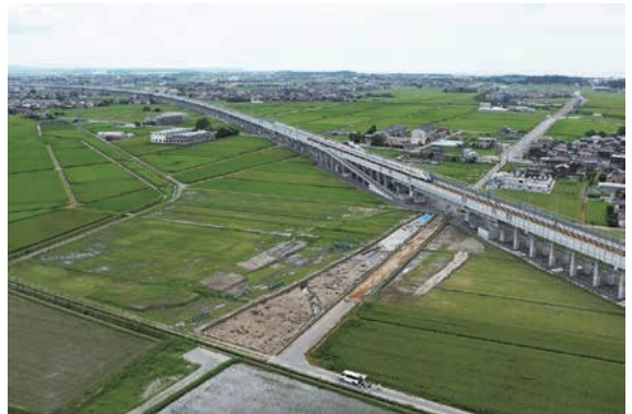
調査地遠景 (北西から)
