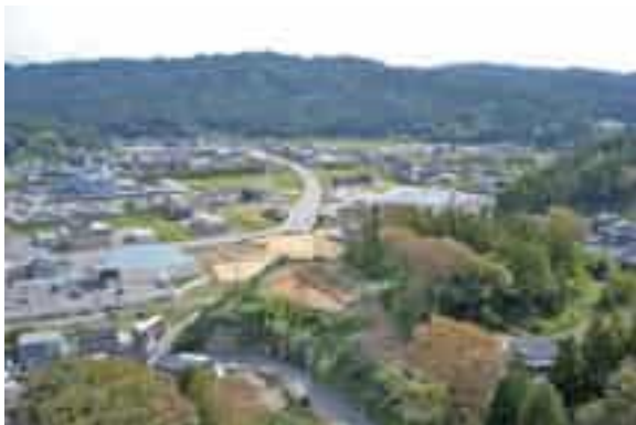
東調査区（C区）の遠景（北西から）
