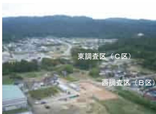
令和5年度調査区の遠景 (北西から)
