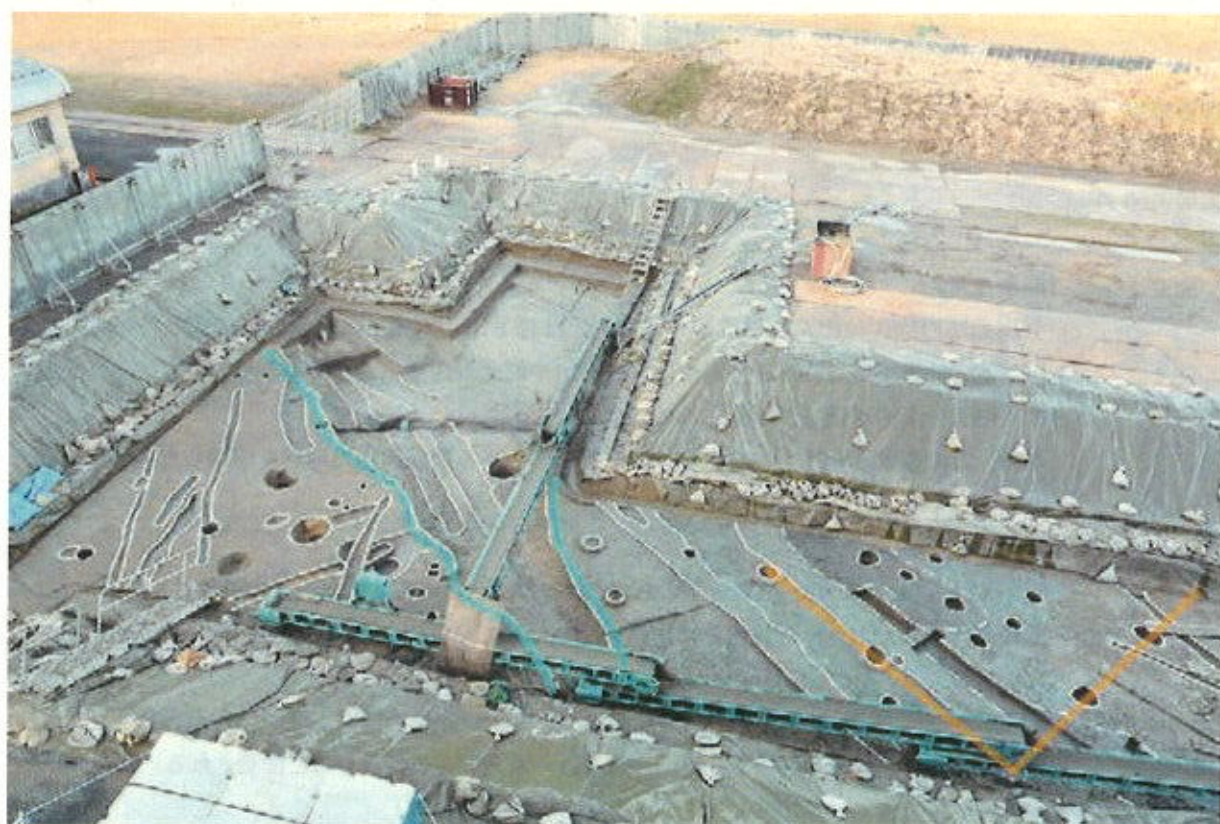
流路に沿う総柱建物（南東から）
