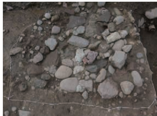
図5 礎石根固め (川原石充填タイプ)
