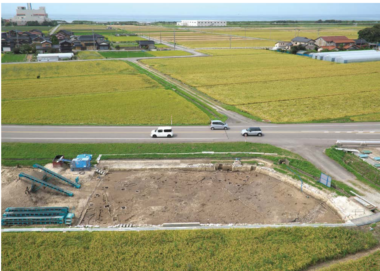
F区全景（南西から）
