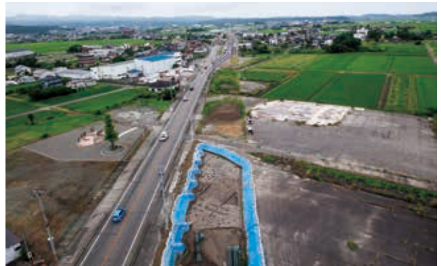
調査区遠景 (V4区・北東から)
