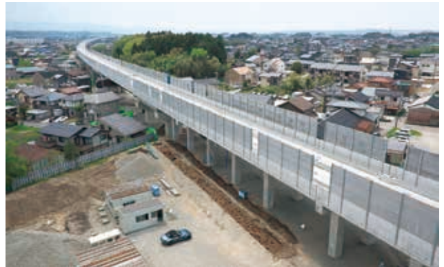
調査地の遠景（北東から）
