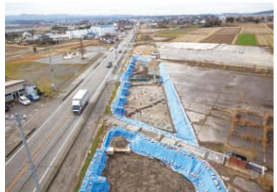
調査区遠景 (V3 区・北東から)
