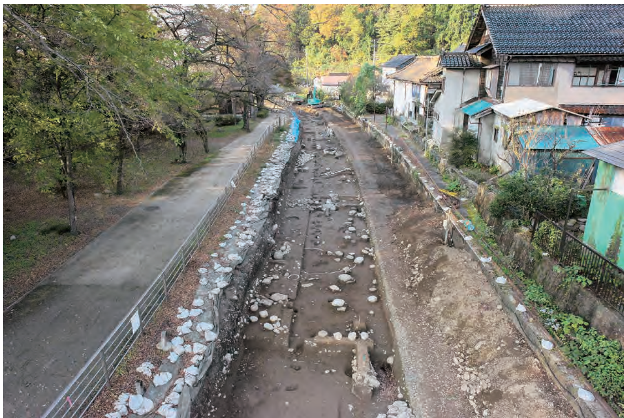
調査区全景（B区4・5面）（南東から）
