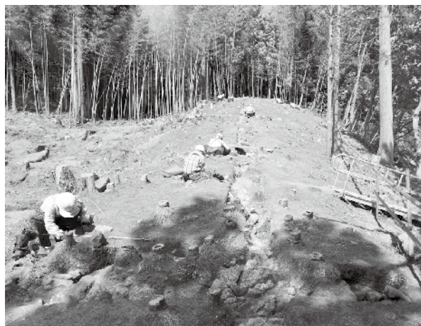
尾根部発掘作業風景(南西から)
