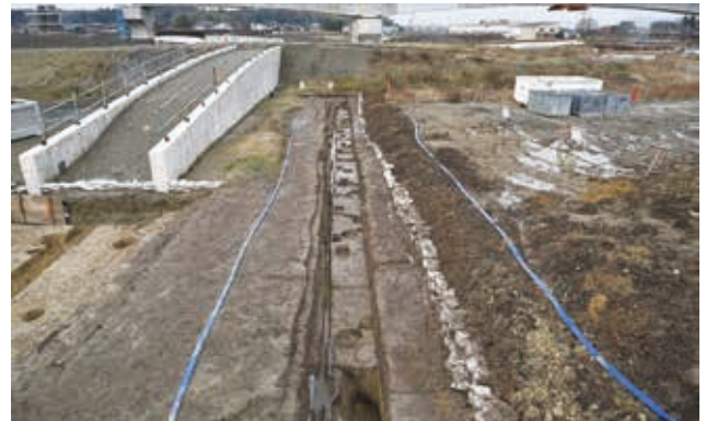
調査区1の全景（南から）
