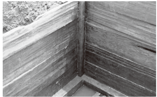
写真8 南東隅柱合わせ目（北西から）
