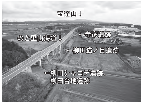
調査地の遠景（北から南方向へ）
