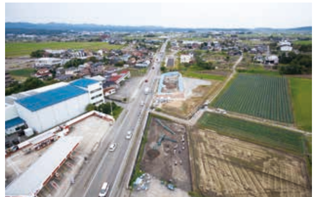
調査区遠景（東から）
