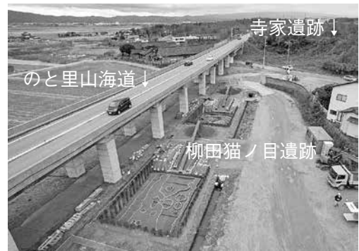
調査地の遠景 (北西から)
