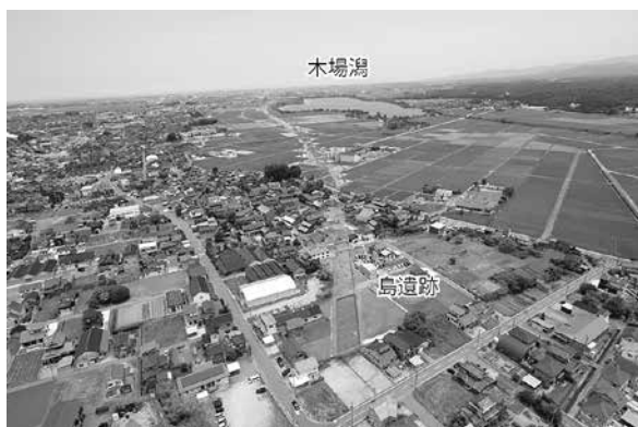
調査地の遠景 (南西から)
