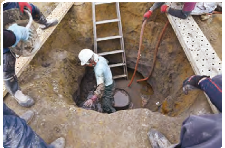
井戸の調査風景
