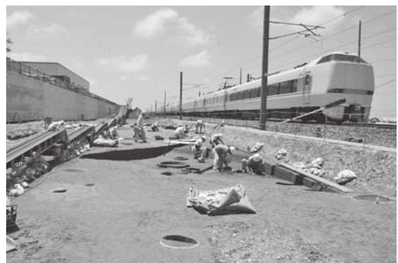
調査の様子（北東から）
