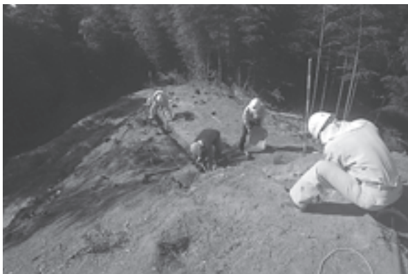
作業風景（斜面部トレンチ掘削）
