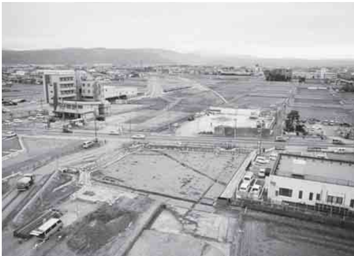
調査区遠景（Ⅰ区：北西から）
