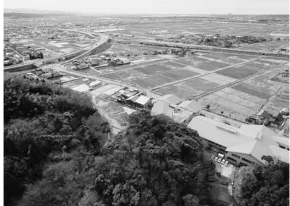
調査区遠景（北東から）
