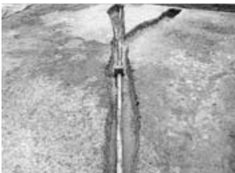
水道管完掘状況 (北から)
