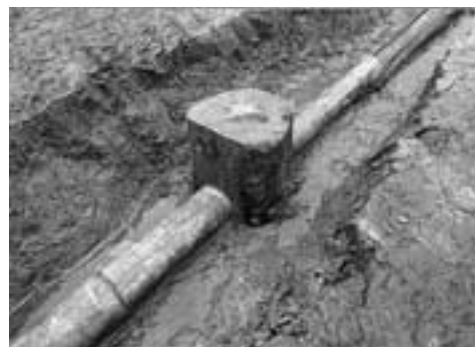
水道管ジョイント部分 (南東から)
