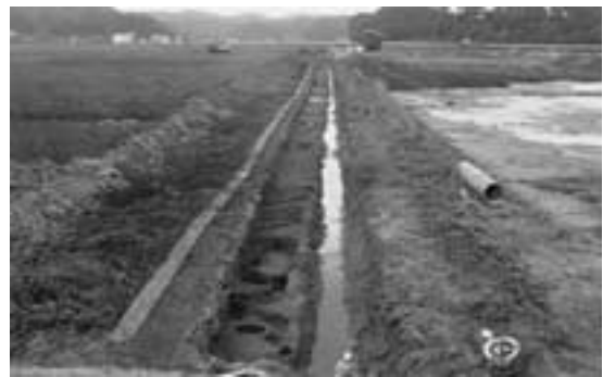
トレンチ③東側完掘状況
