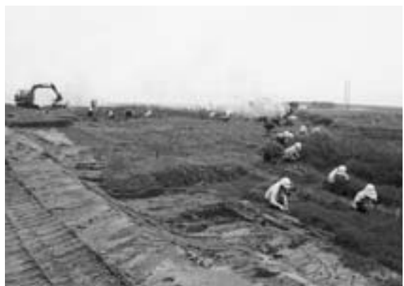
平坦面(中段) 作業風景
