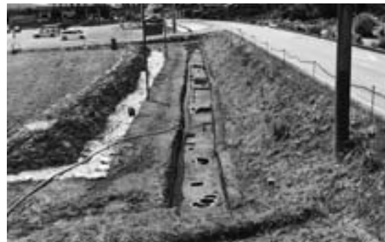
上層完掘状況（北東から）
