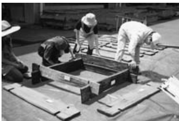
④ 2段目組み立て（図面とあってる？）
