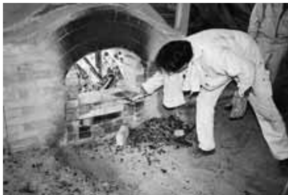
写真11 焚き口閉塞作業風景 1
