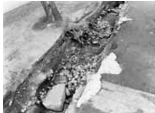
河北二ノ門 石垣台根石（南東から）
