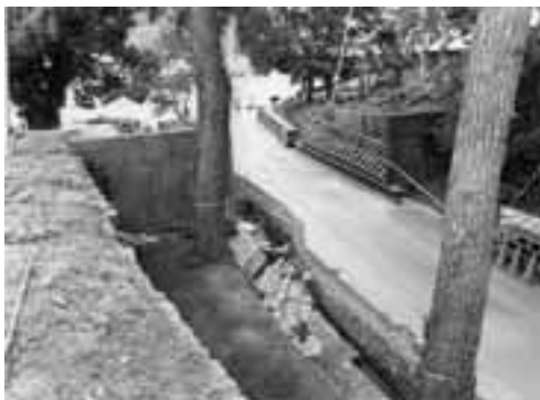
河北一ノ門と石組側溝（北東から）
