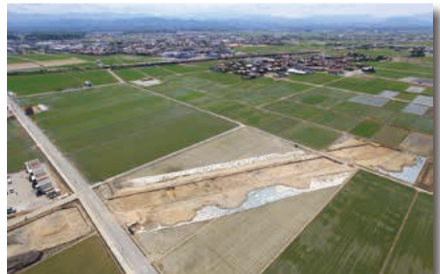
南側調査区全景 (西から)
