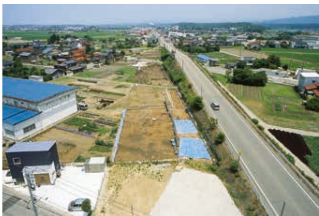
調査地遠景（西より）
